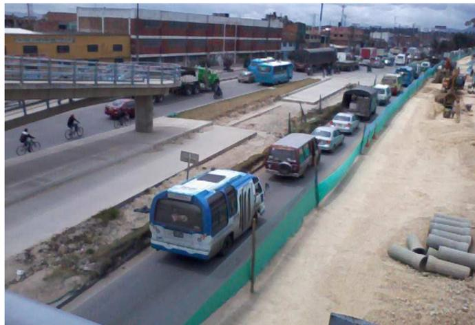
Foto No.8 Intervención Colector sobre calzada mixta constado oriental Autopista Sur, se observan lozas de concreto sin construir por parte de Transmilenio (Fuente equipo auditor)
