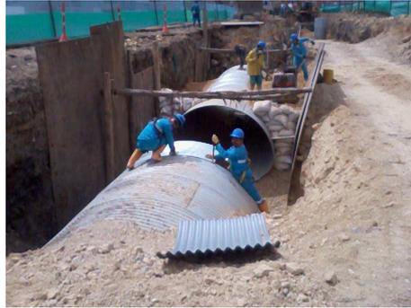
Foto No.1 Instalación tubería Colector tramo 44 al 43 sector avenida terreros (Fuente equipo auditor)
