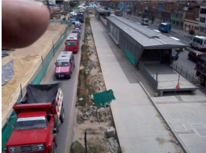
Foto No.9 Intervención Colector sobre calzada mixta constado oriental Autopista Sur, se observan lozas de concreto sin construir por parte de Transmilenio (Fuente equipo auditor)
