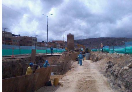
Foto No.2 Instalación tubería Colector tramo 44 al 43 sector avenida terreros (Fuente equipo auditor)
